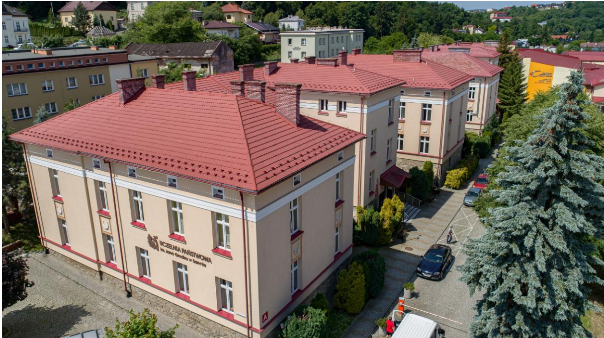
Budynek A i B widok z lotu ptaka
