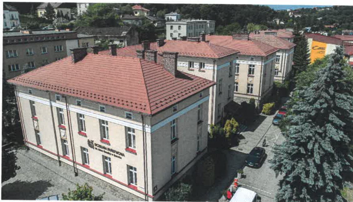
Budynek A i B (ul. Mickiewicza 21)
