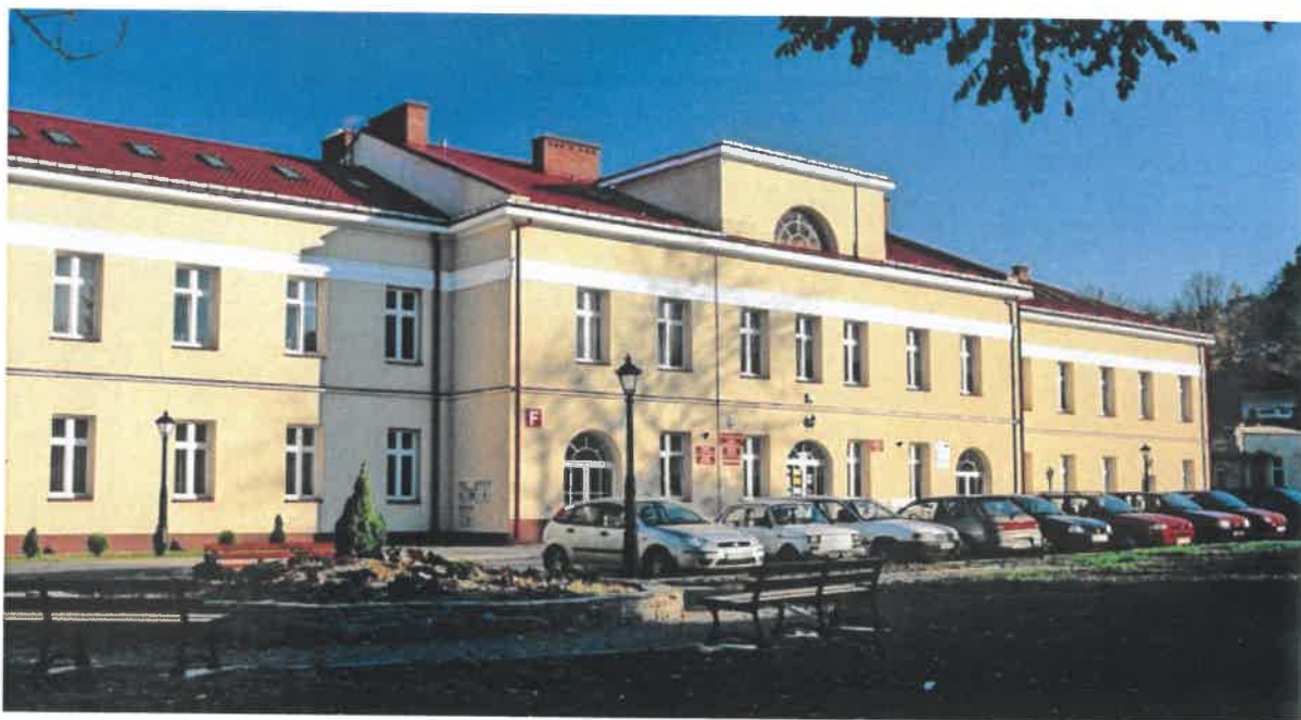
Budynek F (ul. Mickiewicza 21)
