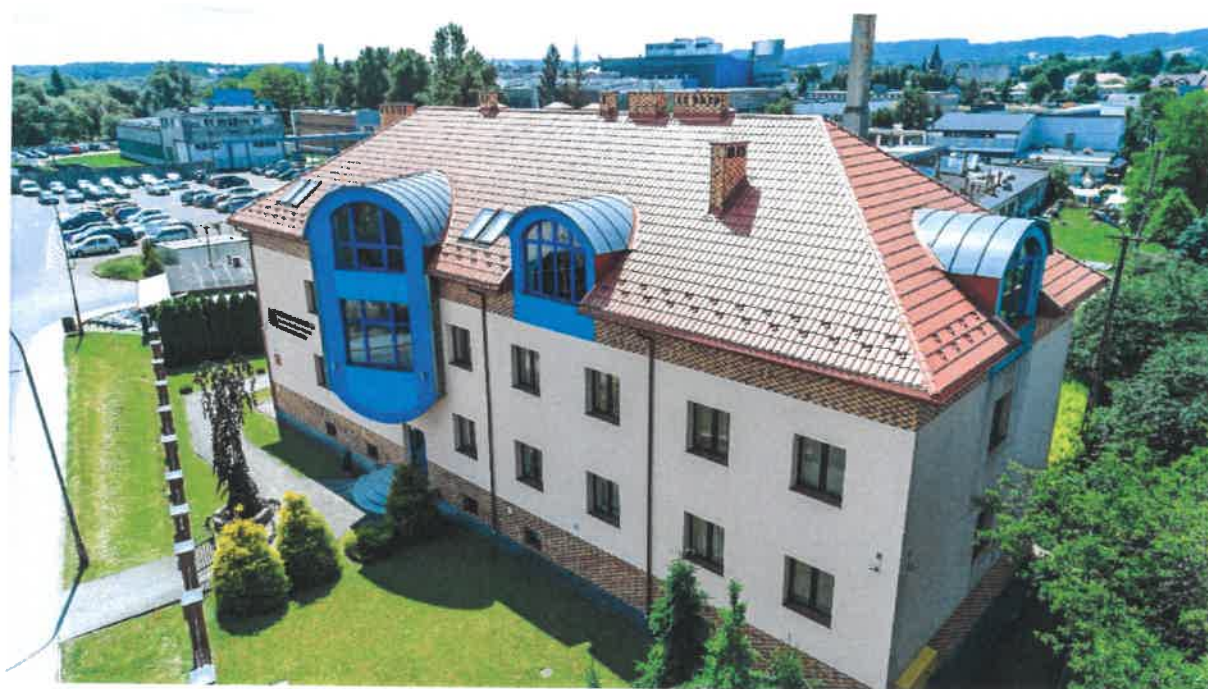
Budynek C (ul. Reymonta 6)
