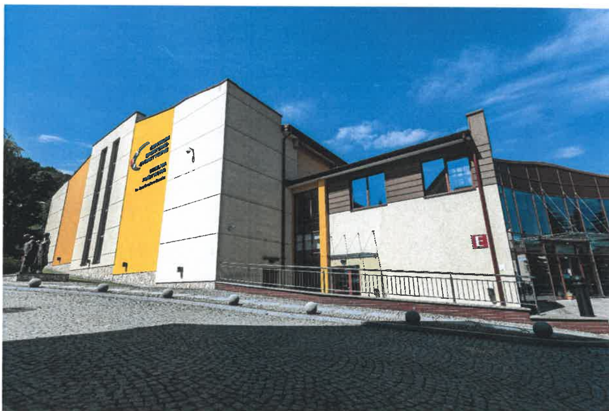
Budynek E – Centrum Sportowo-Dydaktyczne (ul. Mickiewicza 21)
